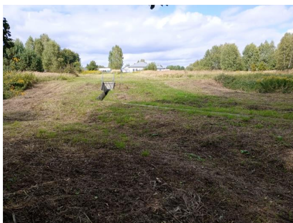
Odływ ścieków oczyszczonych do odbiornika – rzeki Boży Stok (po wykonaniu konserwacji, c.d.).
