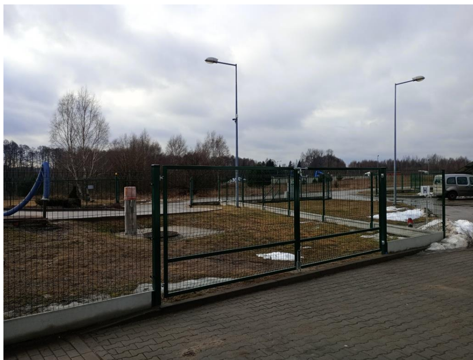
Ogrodzenie wybudowane wokół stacji zlewnej ścieków dowożonych.
