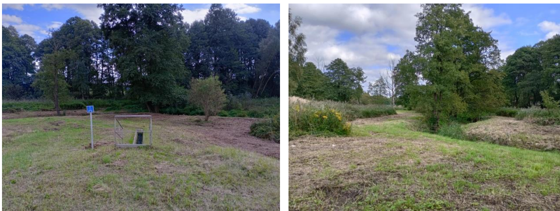
Odływ ścieków oczyszczonych do odbiornika – rzeki Boży Stok (po wykonaniu konserwacji).
