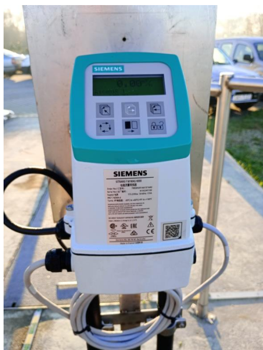
Sterownik przepływomierza Siemens SITRANS F M MAG 6000; zasyfonowany przepływomierz elektromagnetyczny SIEMENS DN 150 wraz z redukcją średnicy kolektora.
