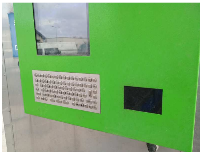
Zdj. Wymieniony panel klawiatury przy systemie przyjmowania ścieków dowożonych „Ścieki Polskie”.
