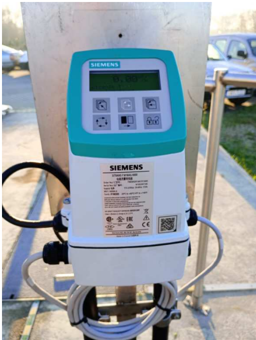
Zdj. Sterownik przepływomierza Siemens SITRANS F M MAG 6000; zasyfonowany przepływomierz elektromagnetyczny SIEMENS DN 150 wraz z redukcją średnicy kolektora.
