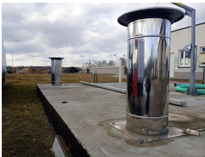
Zdj. Biofiltry kominkowe na jednej z pompowni zlokalizowanych na terenie oczyszczalni ścieków.
