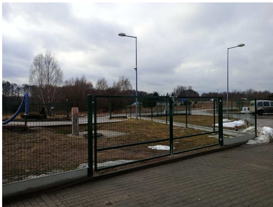
Zdj. Ogrodzenie wybudowane wokół stacji zlewnej ścieków dowożonych.
