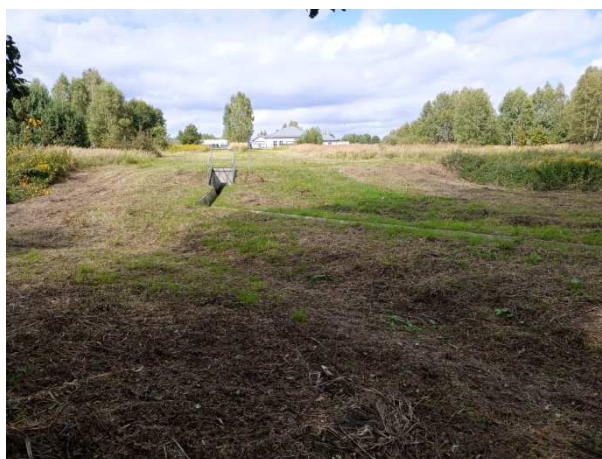
Zdj. Odpływ ścieków oczyszczonych do odbiornika – rzeki Boży Stok po wykonaniu konserwacji (c.d.).
